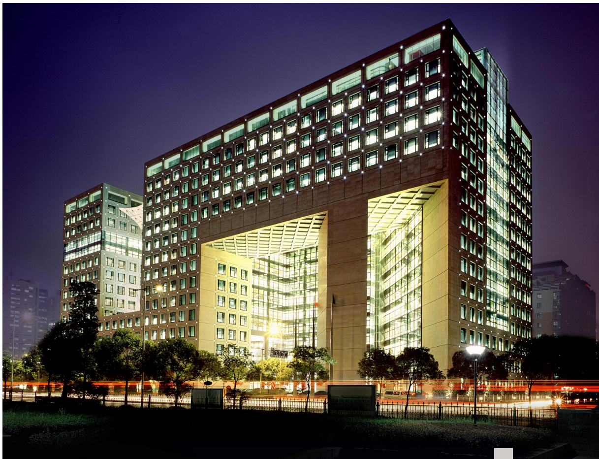
浙江省建工集团承建的浙江省电力生产调度大楼工程获得 2009 年第八届中国土木工程詹天佑奖
